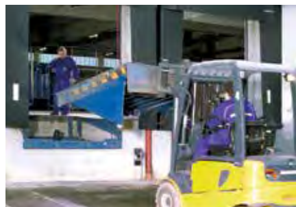
Demontáž starého nakládacího můstku, popř. úprava jámy (např. pomocí montážních desek nebo konzol)
